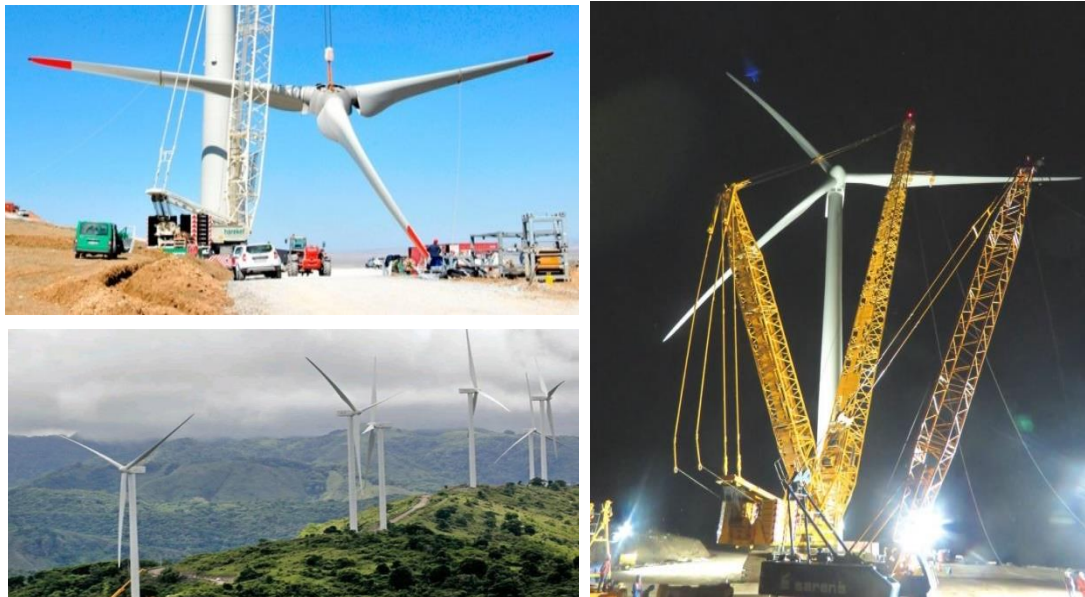
Gambar II.9 Pengerjaan Proyek Pembangkit Listrik Tenaga Bayu (PLTB)
